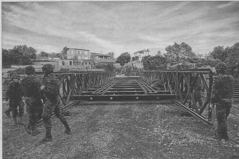
Ocho horas. Los militares llegaron a la orilla del puente ayer a las 8.30 horas y tras algo más de ocho horas de trabajo ininterrumpido, a las cinco de la tarde completaron la instalación de la estructura provisional de 15 metros. Hoy, si el tiempo lo permite, se asfaltarán los accesos y mañana abrirá. Fotos: PERE BOTA
