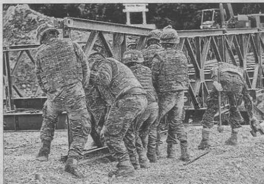
Soldados trabajando en la instalación de la estructura provisional.
