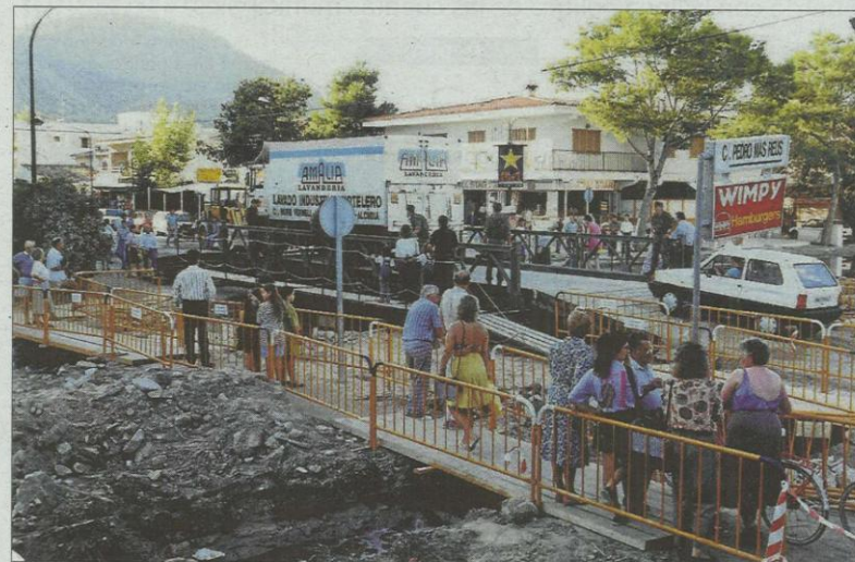
Los vehículos circulan sobre el puente militar, junto al paso peatonal habilitado sobre tablonés.
