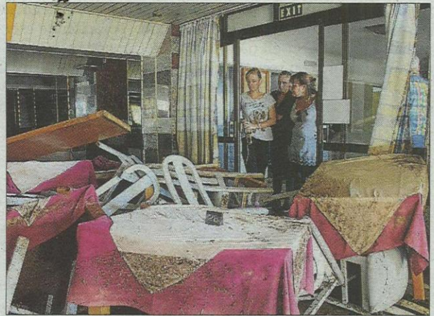
El comedor del hotel Playa Moreia de s'Illot sufrió daños.
