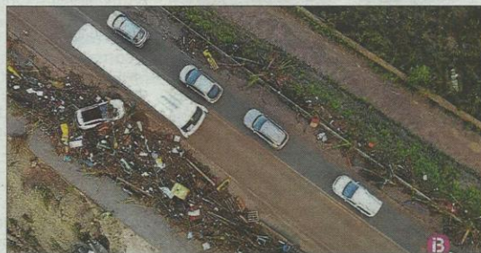
Obstáculos y lodo. Coches, árboles y todo tipo de objetos arrastrados por el agua bloquearon varias carreteras al tráfico. Además, el agua arrastró varios tramos de calzada.
