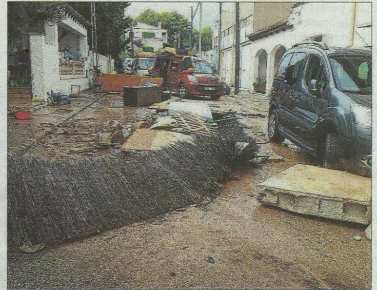
Las calles de la Colònia presentaban ayer cuantiosos daños. Foto: M.NADAL
