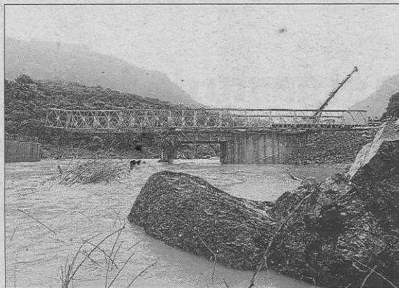
Puente militar desmontable instalado en Ciudad Real.
