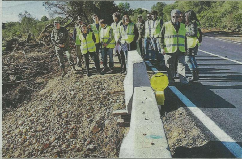
Los políticos comprobaron los daños que provocó la lluvia en las infraestructuras. BIEL CAPÓ
