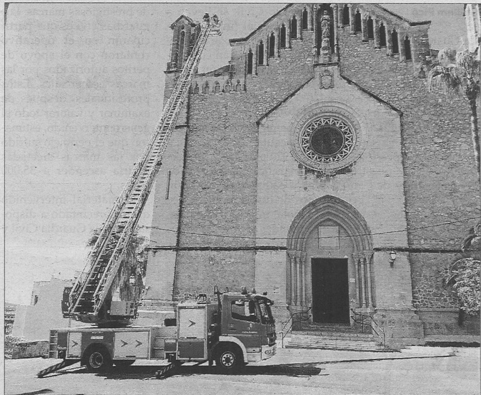
Los bomberos de Manacor revisaron ayer al mediodía la torre dañada por el rayo.
