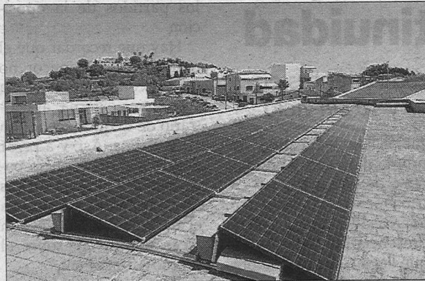
La terraza del colegio ya tiene las placas instaladas.
