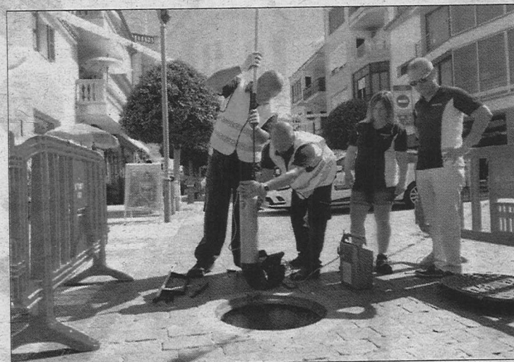
Los operarios de Anticimex introduciendo una de las trampas en la alcantarilla.
