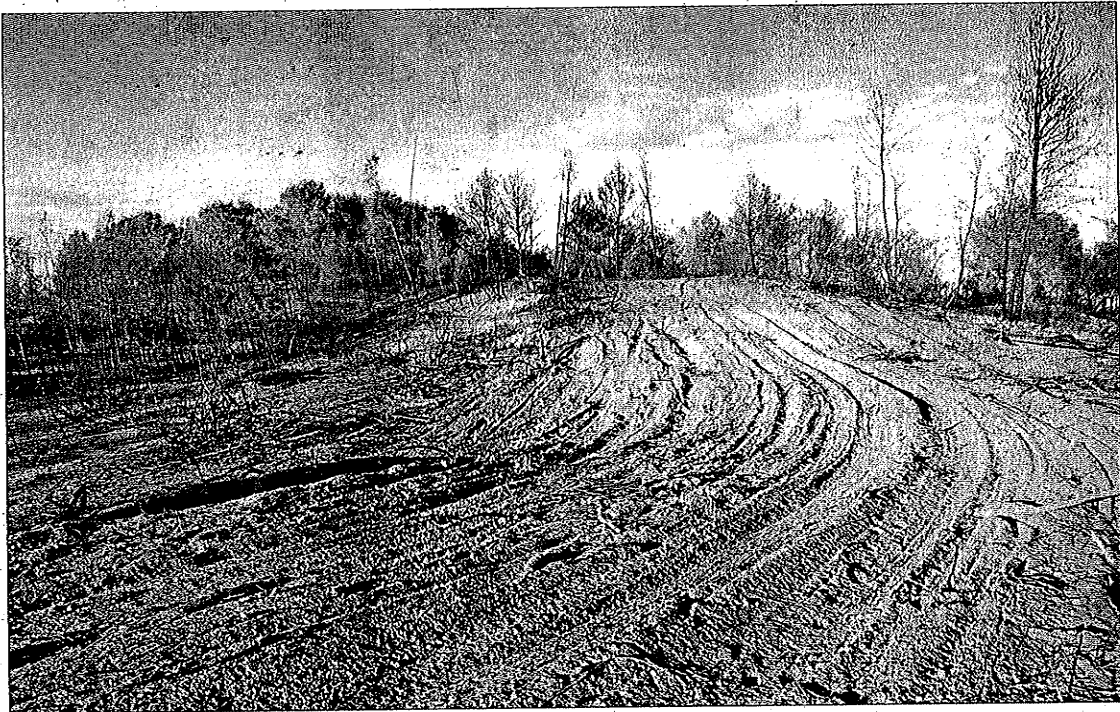
Los trabajos de tala de árboles que se están llevando a cabo. GOB
